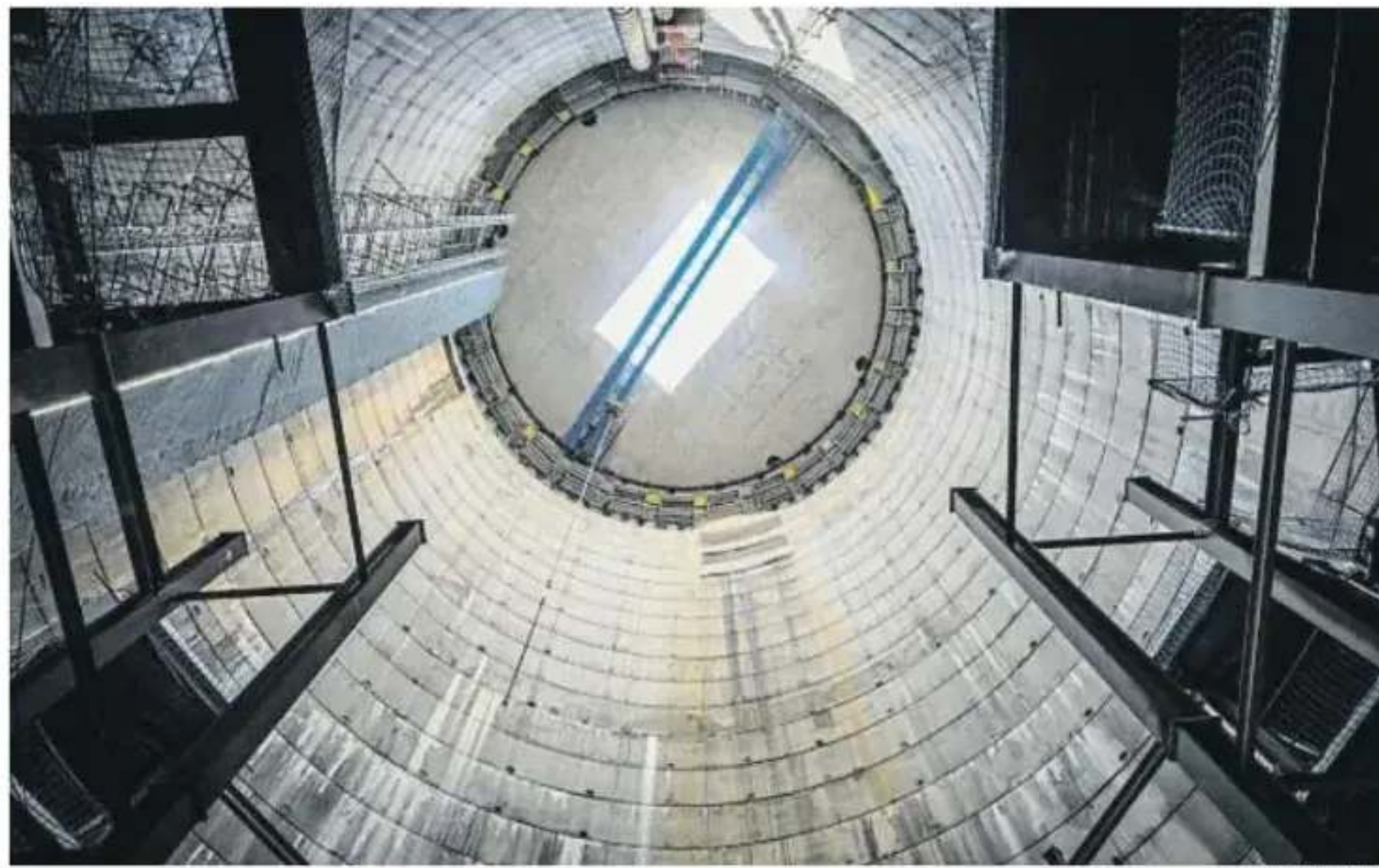
Pozo de la futura estación de la L9 en la plaza Maragall de Barcelona
