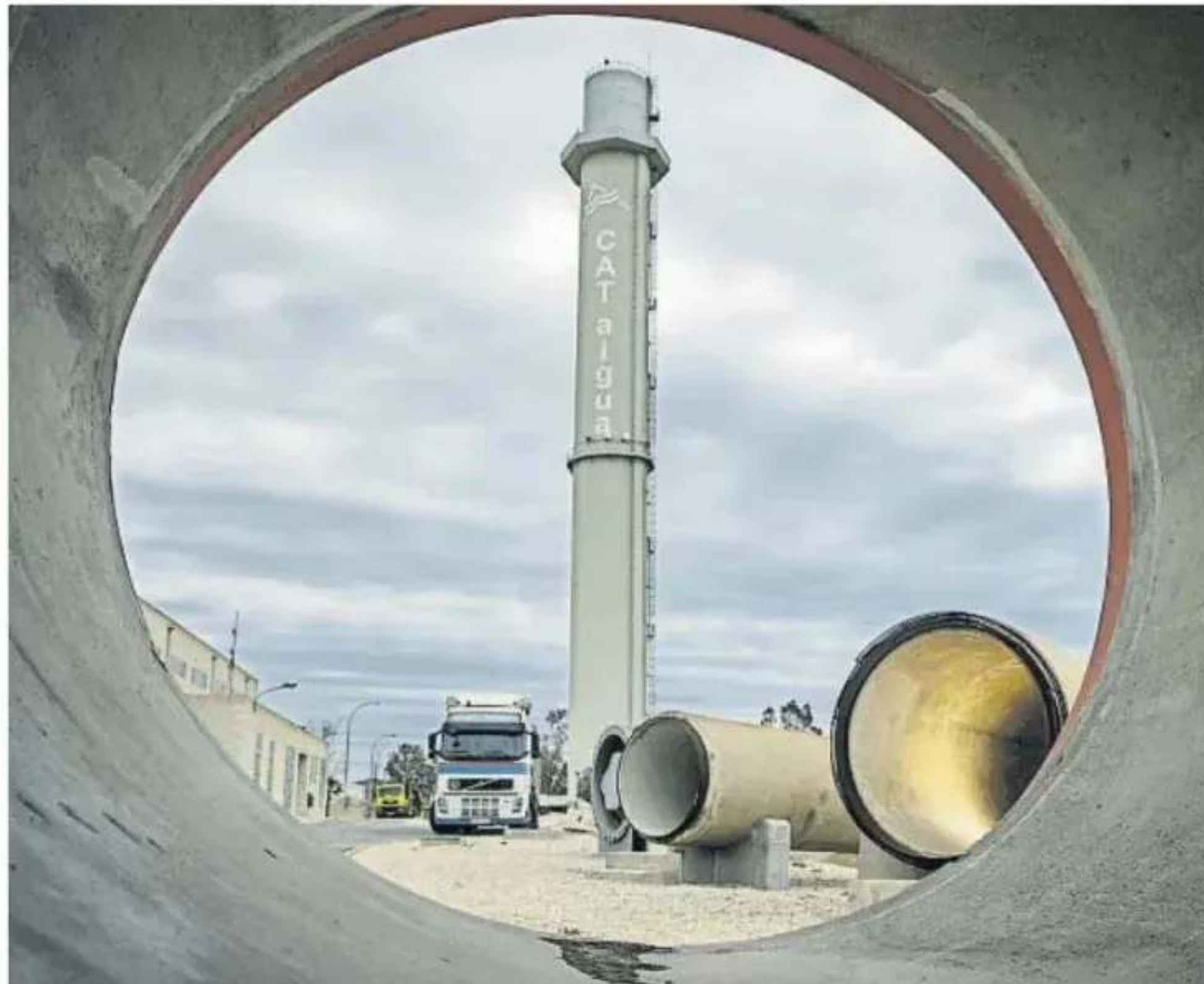
Las instalaciones de la planta depuradora de L'Ampolla del Consorci d'Aigües de Tarragona
